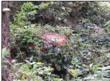
Captage n° 5 : avant
