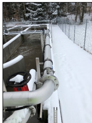
Modification de la tuyauterie inox d'alimentation en air des tuyaux d'aération
