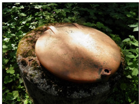
Captage n° 13 : avant
