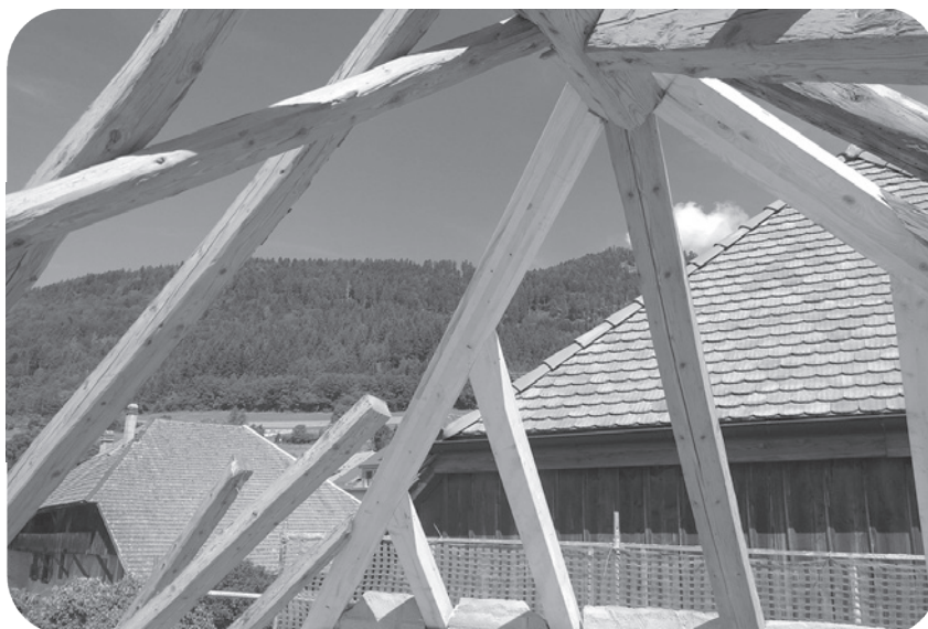
Rénovation d'une charpente
