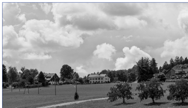
N° 7 - Le collège de la Goille, depuis la Route du Jorat
