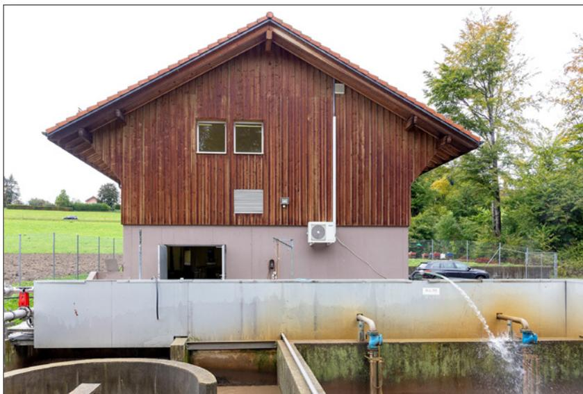
Actuellement, ses installations traitent plus de 470'000 m<sup>3</sup> d'eau souillée par année, dont elles extraient plus de 70 tonnes de matière déshydratée et 6 tonnes de sable. Les boues asséchées par une centrifugeuse sont envoyées pour incinération à Vidy et le sable est évacué en décharge.
