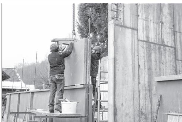
Des éléments préfabriqués en béton armé ont été ajoutés de manière verticale et horizontale pour éviter que le vent souffle contre la paroi et que l'eau coule le long des murs, protégeant ainsi la molasse. Les plaques de molasse bleue utilisées proviennent de la carrière de Villarlod dans le canton de Fribourg où elles ont été taillées au millimètre près par des outils numériques.
