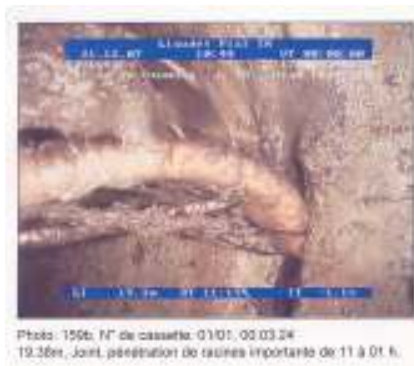
Pénétration importante de racines par un joint
