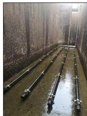
Les aérateurs proposés sont des diffuseurs à plaque qui sont posés directement en fond de bassin, procurant une meilleure diffusion d'air à bulles ultrafines et régulières et supprimant pratiquement les dépôts de boues que nous devons régulièrement pomper et remettre dans le cycle de traitement, y compris lors de la vidange des bassins pour révision.
